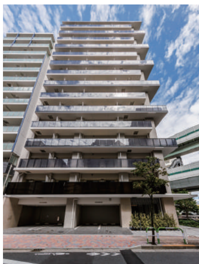
クレストコート 王子 令和8年9月竣工
