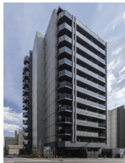
S-RESIDENCE松戸Cosmea 令和7年1月竣工
