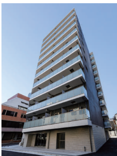
AZEST関内 令和5年2月竣工
