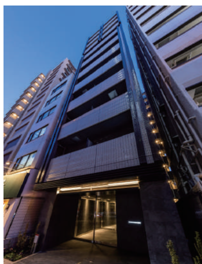
GRAND CONCIERGE駒沢大学 令和6年1月竣工
