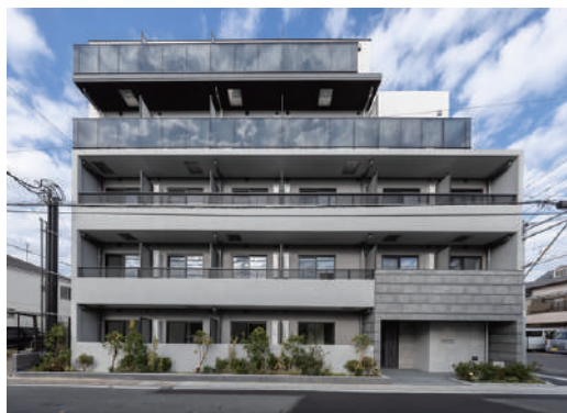
S-RESIDENCE行徳 令和7年11月竣工
