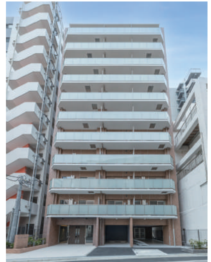
Alivis川崎 令和8年2月竣工
