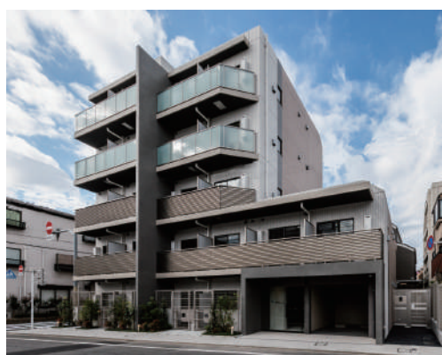
REGOLITH板橋本町 令和7年10月竣工
