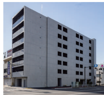
SQUARE CITY YOKOHAMA NEGISHI 令和8年1月竣工
