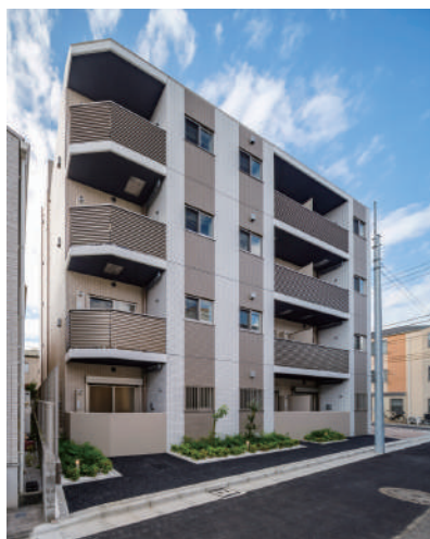
アイルグランデ赤羽 令和7年10月竣工
