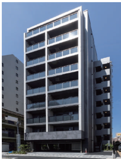
ARKMARK竹ノ塚 令和8年7月竣工
