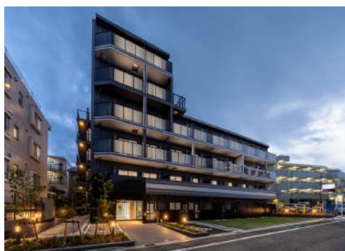
ARKMARK世田谷站 令和7年6月竣工
