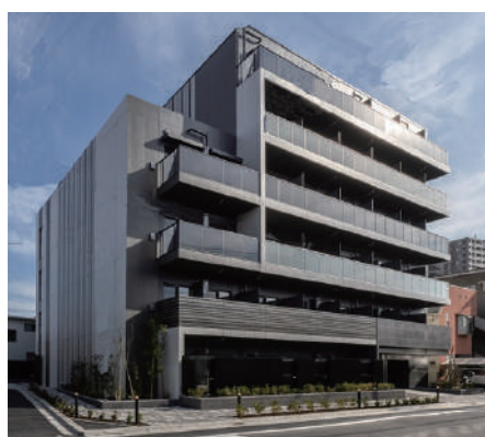
GENOVIA西新井 令和7年12月竣工
