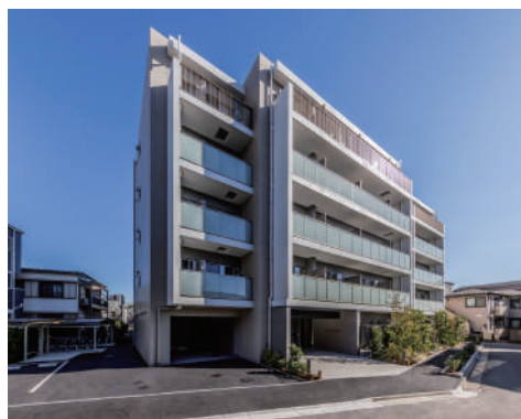
Alivis綾瀬 令和8年1月竣工
