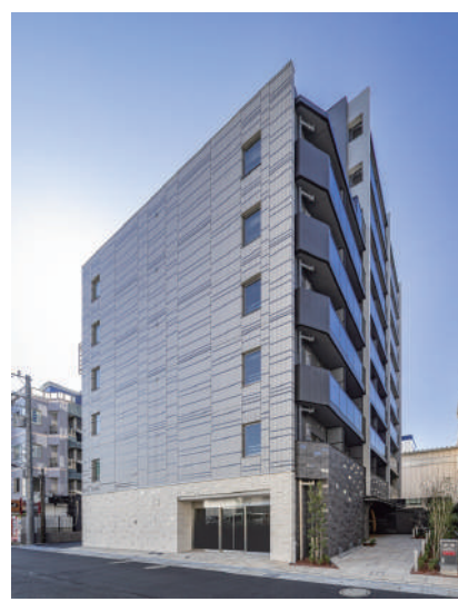
URBANPARK 行徳 STATION FRONT 令和5年11月竣工
