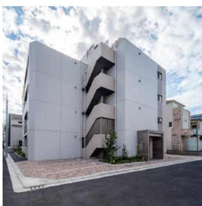
アイル グランデ赤羽 令和7年10月竣工
