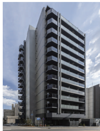
S-RESIDENCE松戸Cosmea 令和7年1月竣工
