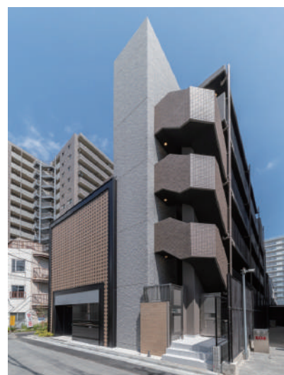
リテラス清澄白河 令和6年5月竣工
