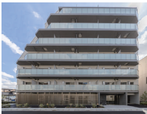
GENOVIA北千住 令和8年5月竣工
