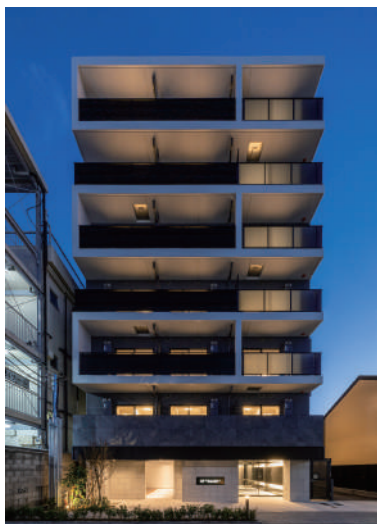
ガリシア竹ノ塚 令和6年11月竣工
