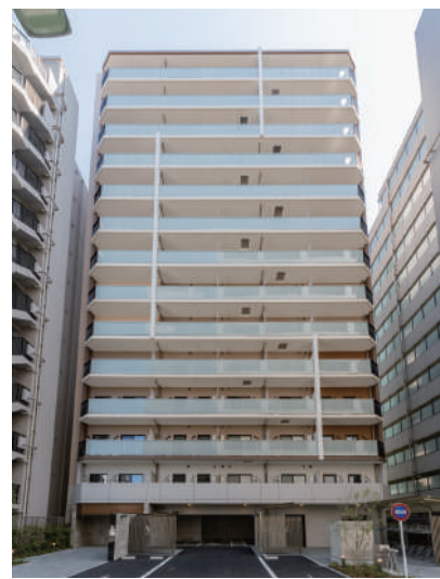
JP noie 西蒲田 令和7年5月竣工
