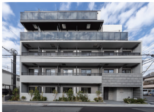
S-RESIDENCE行徳 令和7年11月竣工
