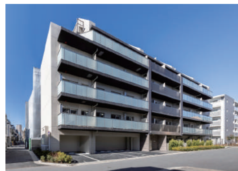
リテラス日暮里 令和6年1月竣工
