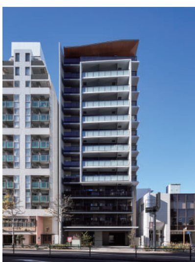
ラティエラ四谷 令和7年1月竣工
