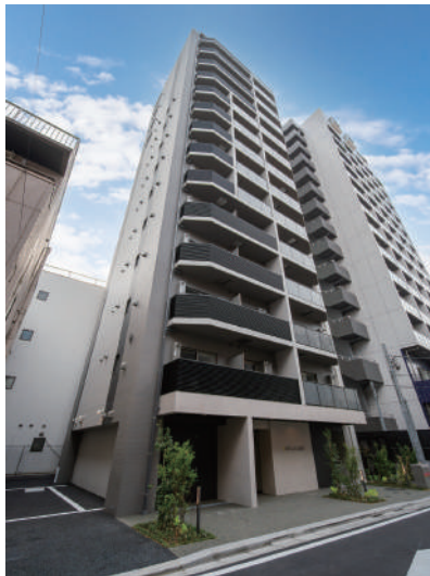
ルミークアン北上野 令和7年12月竣工
