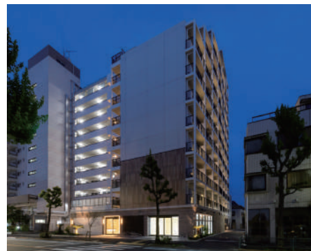
ALTERNA中野 令和5年5月竣工
