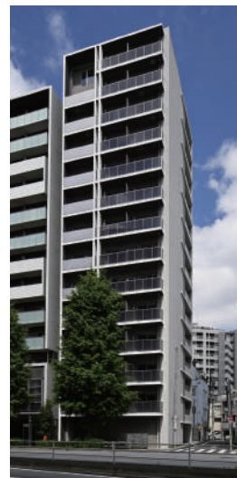
ハウスフラッツ蔵前 令和7年5月竣工
