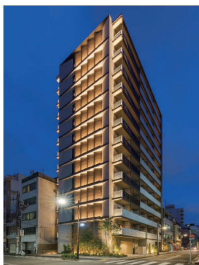
リーラ浅草橋 令和3年7月竣工
