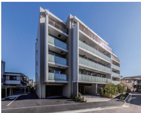
Alivis綾瀬 令和8年1月竣工
