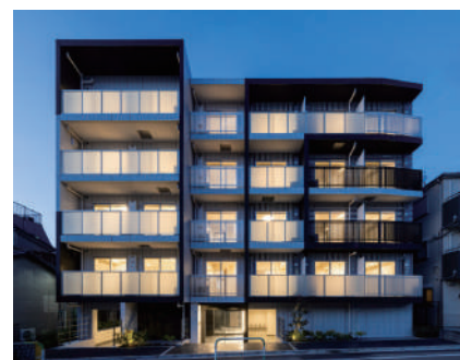
LUMEED赤羽NORTH 令和5年12月竣工
