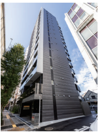
ARKMARK渋谷初台 令和5年11月竣工
