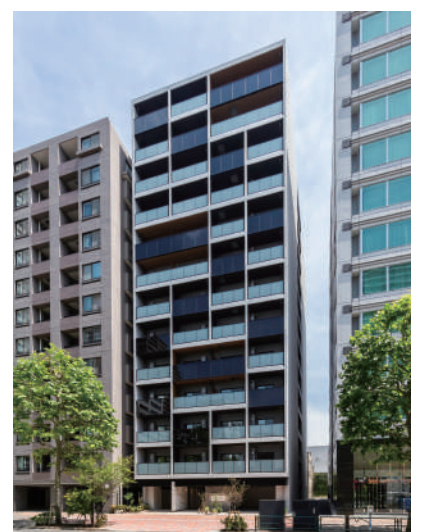
ミュプレ月島 令和3年5月竣工
