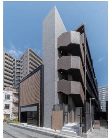
リテラス清澄白河 令和6年5月竣工
