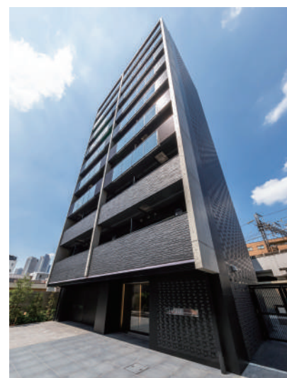
REALIZE新丸子 令和3年7月竣工
