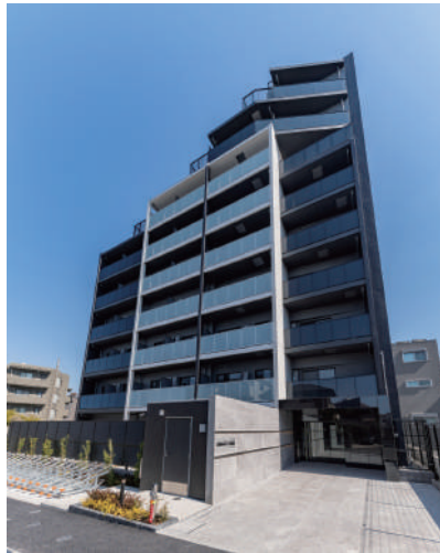
アーバンパーク綾瀬WEST 令和7年3月竣工
