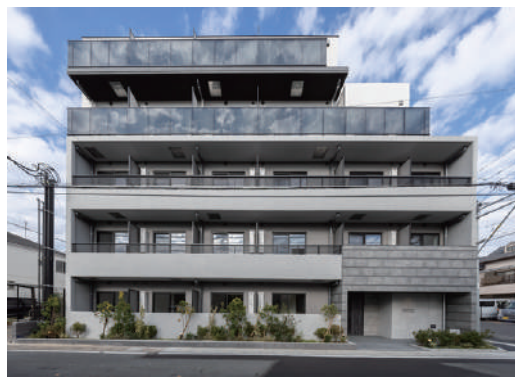
S-RESIDENCE行徳 令和7年11月竣工
