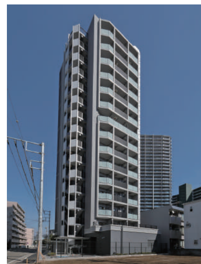
バウスクロス相模大野 令和4年2月竣工
