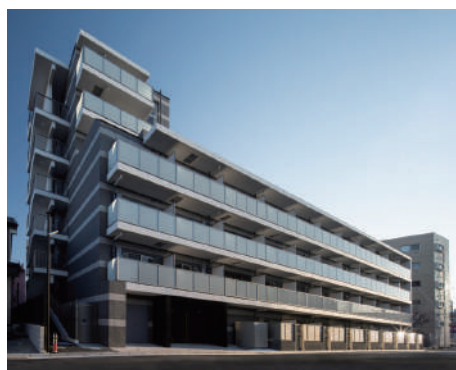
MAXIV西川口SC 令和5年12月竣工
