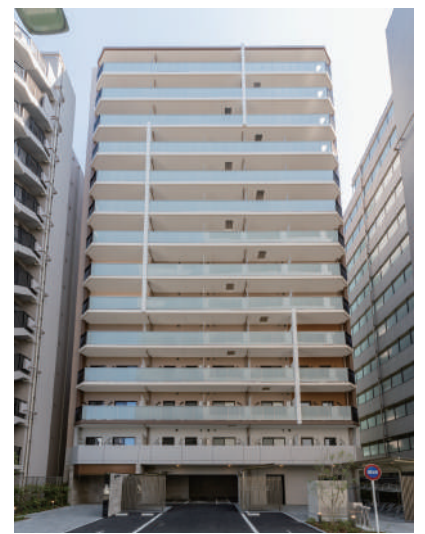
JP noie 西蒲田 令和7年5月竣工
