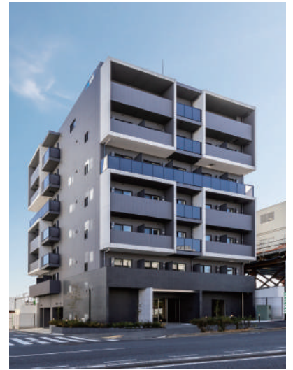
ステージファースト洗足池 令和5年1月竣工
