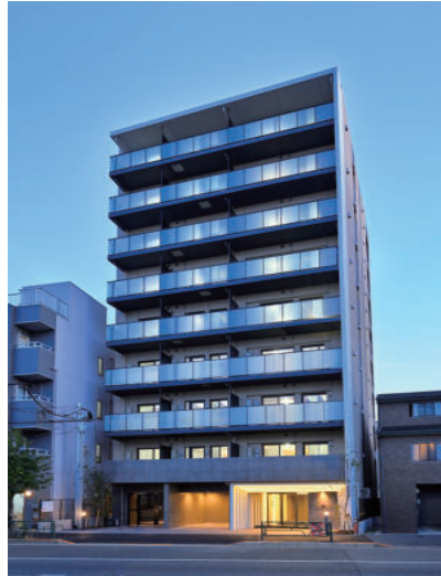
ドゥーエ南砂町 令和6年2月竣工
