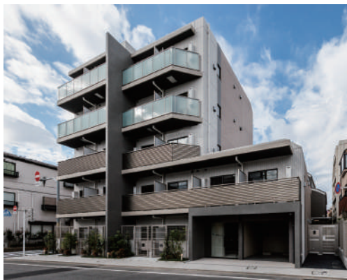
REGOLITH板橋本町 令和7年10月竣工
