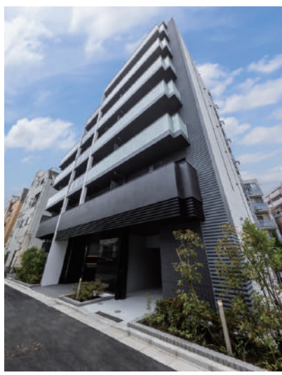
GENOVIA 押上II 令和5年6月竣工
