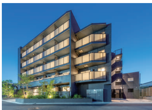
ガーラ・パークヒルズ町田 令和3年7月竣工
