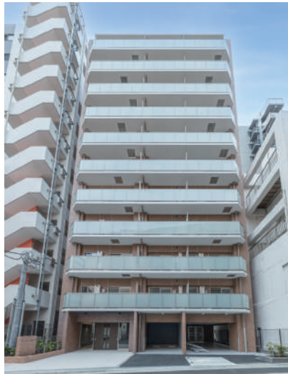
Alivis川崎 令和8年2月竣工
