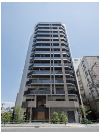
シーズンフラッツ蒲田 令和5年5月竣工
