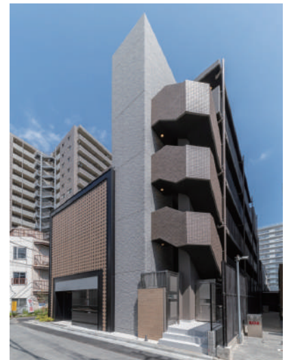
リテラス清澄白河 令和6年5月竣工
