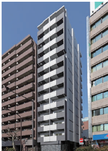
クレイシア三田 平成26年1月竣工
