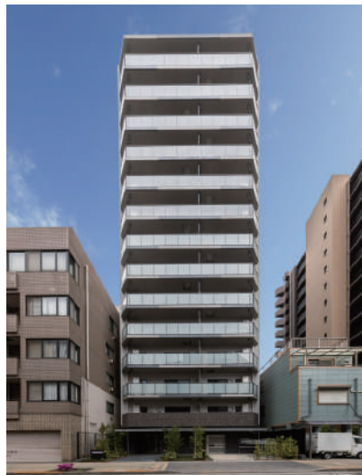
クレストコート上野 令和6年4月竣工
