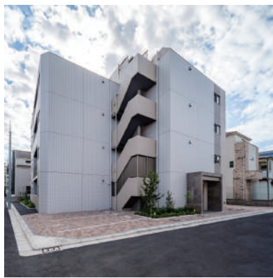
アイル グランデ赤羽 令和7年10月竣工
