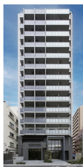
クレストコート池上 令和7年3月竣工
