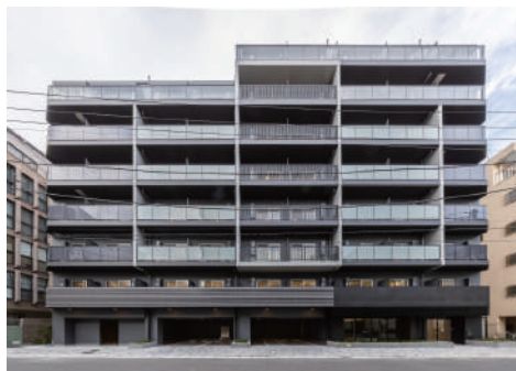
Weave Place錦糸町 令和6年8月竣工
