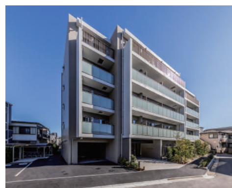
Alivis綾瀬 令和8年1月竣工
