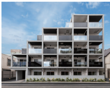
REALIZE新小岩 令和2年7月竣工
