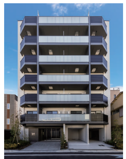
プレール・ドック木場公園WEST 令和5年2月竣工
