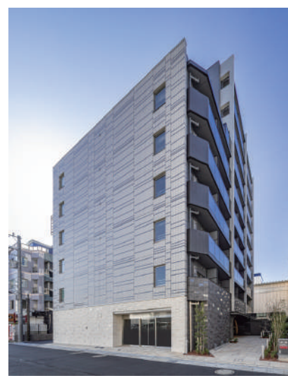
URBANPARK 行徳 STATION FRONT 令和5年11月竣工
