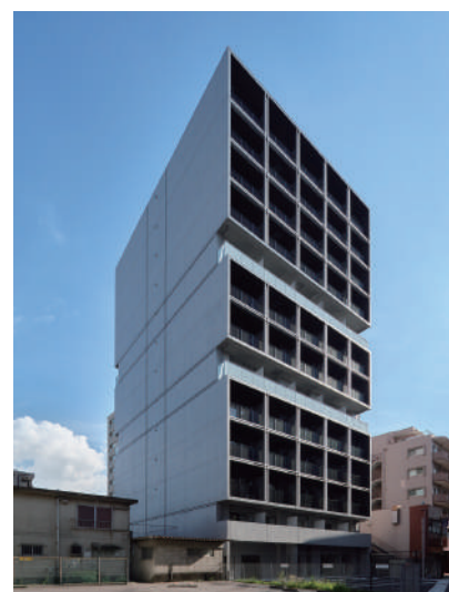
ステージグランデ本千葉 令和7年7月竣工
