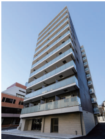
AZEST関内 令和5年3月竣工
