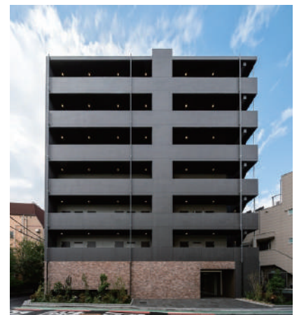
ガリシア四ツ木テラス 令和7年10月竣工
