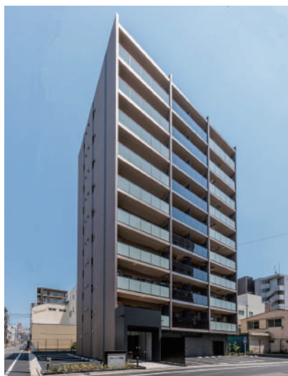
BPRレジデンス東日暮里 令和7年7月竣工
