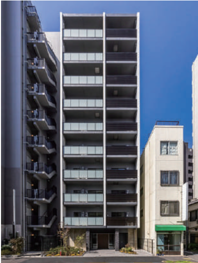
クレストコート両国 令和6年3月竣工
