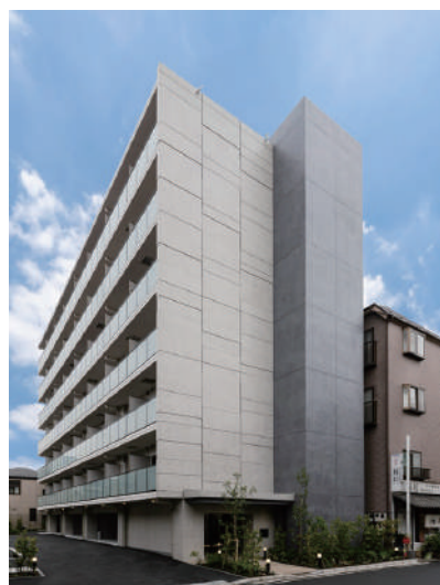
ヴォーガコルテ川崎平間 令和7年11月竣工
