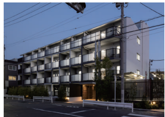
クレストコート池上六丁目 令和7年3月竣工
