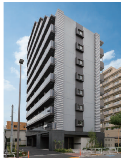
ガーラ・ヴィスタ大島 令和6年9月竣工
