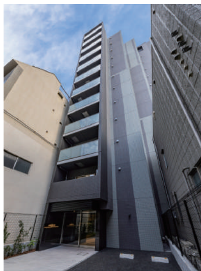
ARKMARK浅草 令和6年7月竣工
