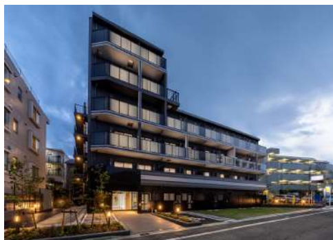
ARKMARK世田谷砦 令和7年6月竣工
