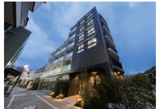
クレストコート渋谷笹塚 令和6年3月竣工
