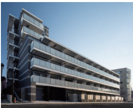
MAXIV西川口SC 令和5年12月竣工
