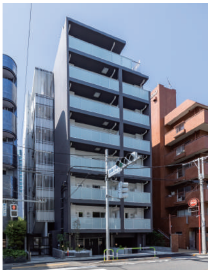
タスキプライム テラス後樂園 令和7年5月竣工
