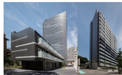
AXASレジデンス目黒東 令和元年5月竣工
