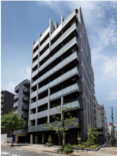
GEOVIA木場 II 令和5年6月竣工
