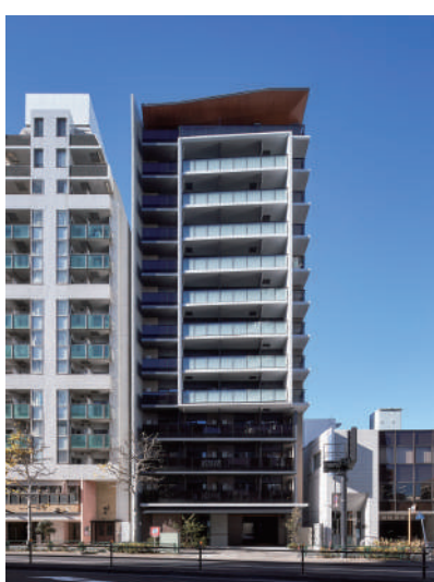
ラティエラ四谷 令和7年1月竣工
