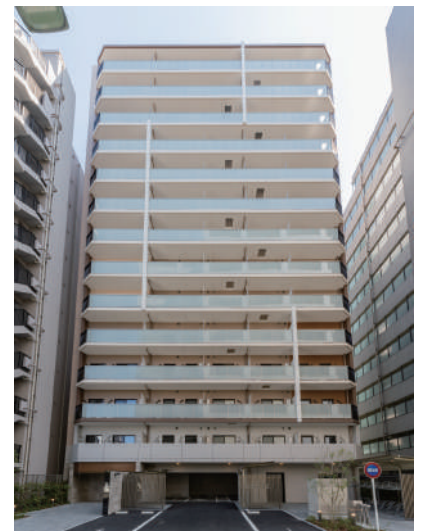
JP noie 西蒲田 令和7年5月竣工
