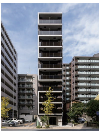
ステージファースト横浜 令和4年10月竣工
