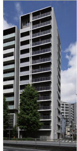
ハウスフラッツ蔵前 令和7年5月竣工
