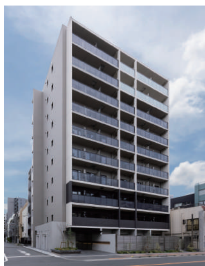
ALTERNA浅草 令和5年9月竣工
