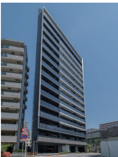
GALA STATION 大森海岸 令和5年5月竣工
