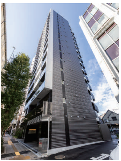
ARKMARK渋谷初台 令和5年11月竣工
