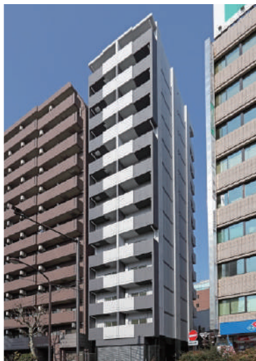
クレイシア三田 平成26年1月竣工
