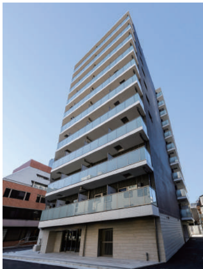
AZEST関内 令和5年3月竣工
