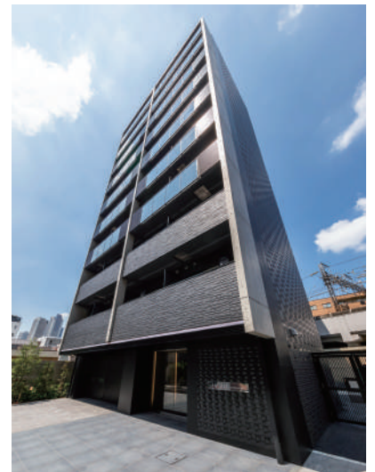
REALIZE新丸子 令和3年7月竣工
