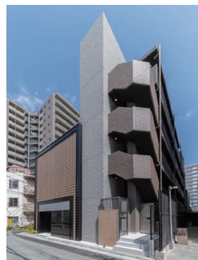
リテラス清澄白河 令和6年5月竣工
