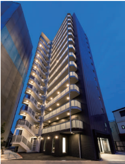
AZEST青砥 令和2年1月竣工
