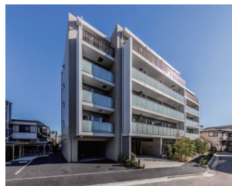
Alivis綾瀬 令和8年1月竣工
