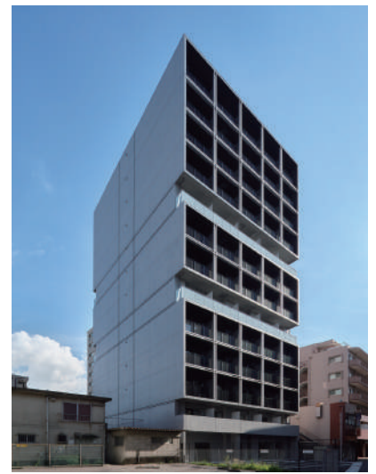
ステージグランデ本千葉 令和7年7月竣工
