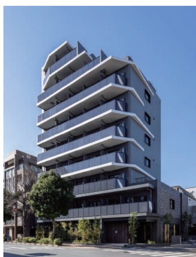
バウスフラッツ高円寺 令和4年12月竣工
