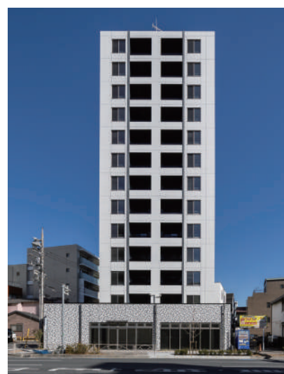
タスキプライム テラス本蓮沼 令和8年2月竣工
