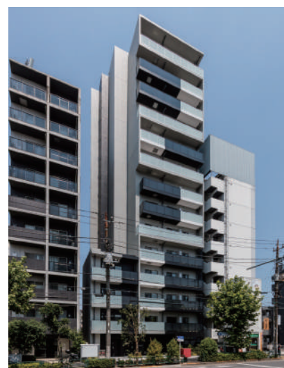
Alivis東京尾久 令和7年7月竣工
