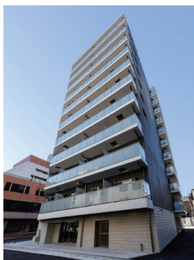
AZEST関内 令和5年2月竣工
