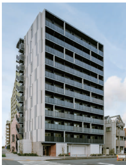
ラ・メゾン川崎六番館 令和4年3月竣工
