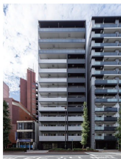
ステージグランド八王子Ⅲ 令和6年8月竣工
