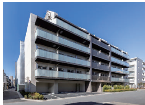
リテラス日暮里 令和6年1月竣工
