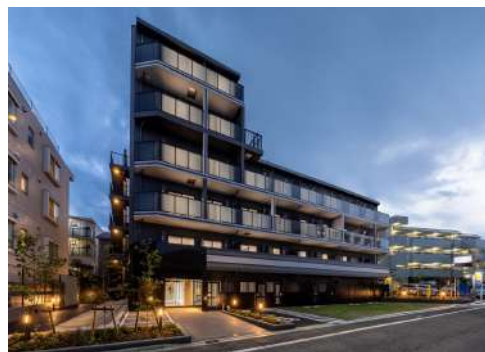
ARKMARK世田谷站 令和7年6月竣工
