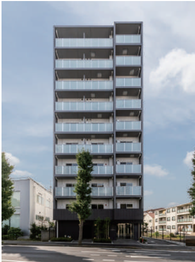
GENOVIA白糸台skygarden 令和5年10月竣工
