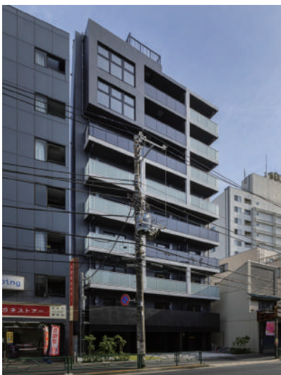
ARKMARK方南町Sta. 令和7年5月竣工
