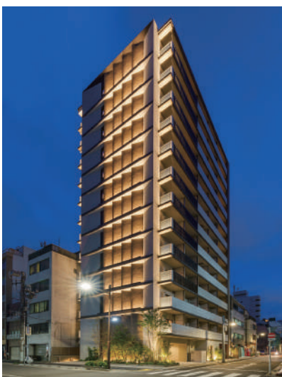
リーラ浅草橋 令和3年7月竣工
