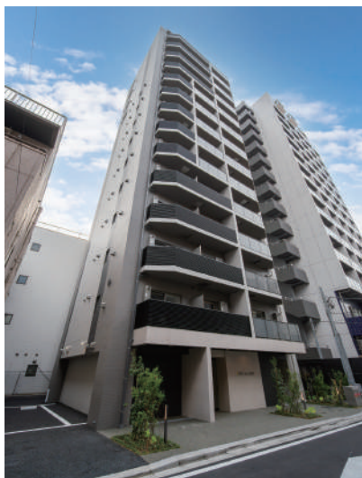
ルミークアン北上野 令和7年12月竣工
