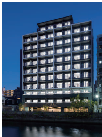
ガーラ・リバーズクエア横浜南 令和3年12月竣工
