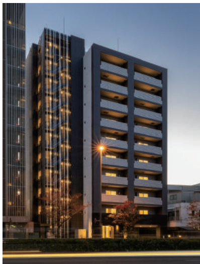
ACPLレジデンス西巣鴨 令和6年11月竣工
