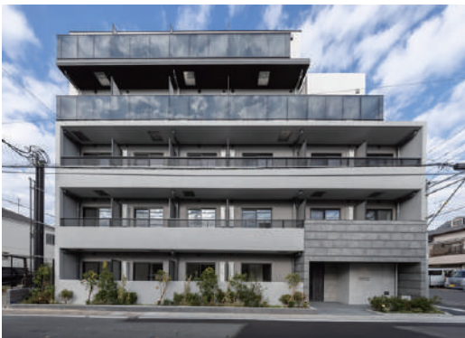
S-RESIDENCE行徳 令和7年11月竣工
