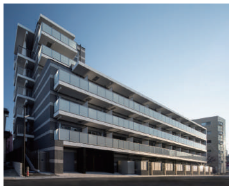
MAXIV西川口SC 令和5年12月竣工
