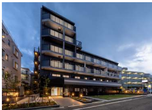
ARKMARK世田谷站 令和7年6月竣工
