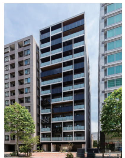
ミュプレ月島 令和3年5月竣工
