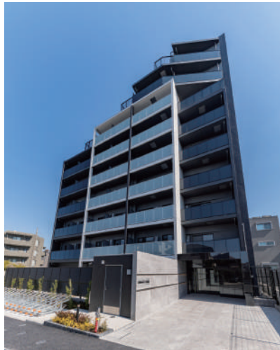
アーバンパーク綾瀬WEST 令和7年3月竣工
