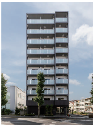
GENOVIA白糸台skygarden 令和5年10月竣工
