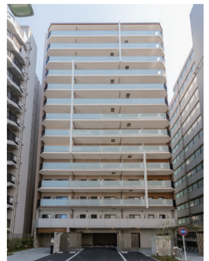
JP noie 西蒲田 令和7年5月竣工
