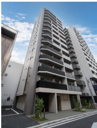
ルミークアン北上野 令和7年12月竣工
