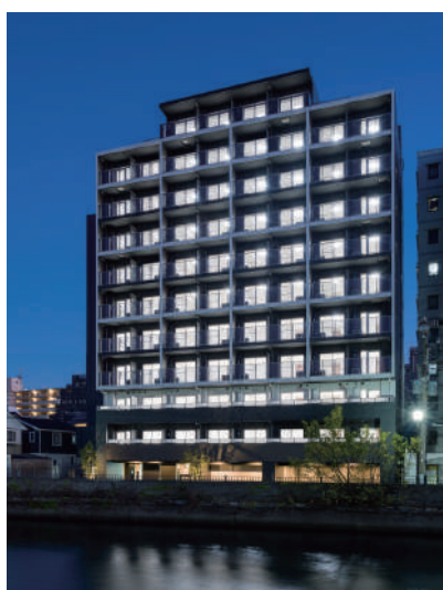
ガーラ・リバーズクエア横濱南 令和3年12月竣工
