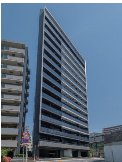
GALA STATION 大森海岸 令和5年5月竣工
