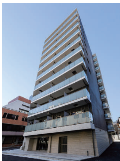
AZEST関内 令和5年2月竣工
