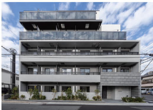
S-RESIDENCE行徳 令和7年11月竣工
