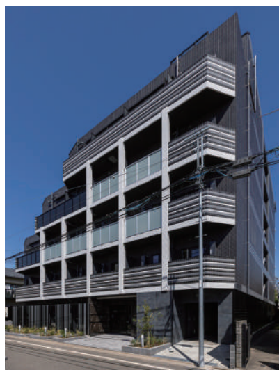
アーバンパーク江古田の森 令和7年4月竣工
