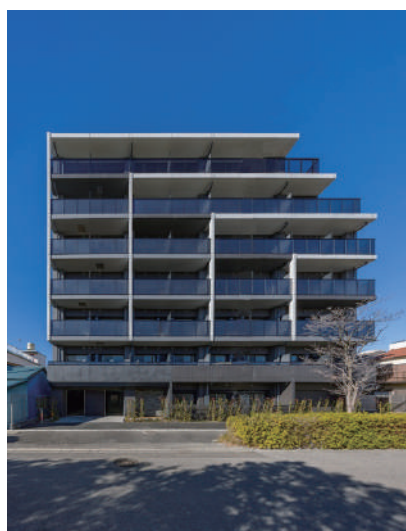
ガーラ・プレシャス四ツ木 令和8年1月竣工
