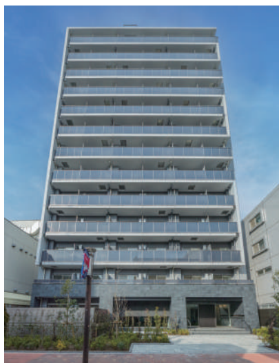
ガーラ・ステーション川崎平間 令和8年2月竣工
