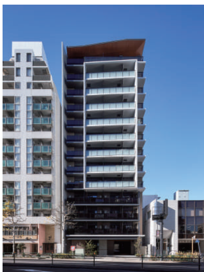
ラティエラ四谷 令和7年1月竣工
