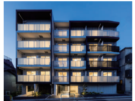
LUMEED赤羽NORTH 令和5年12月竣工
