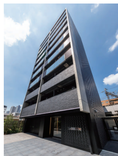
REALIZE新丸子 令和3年7月竣工
