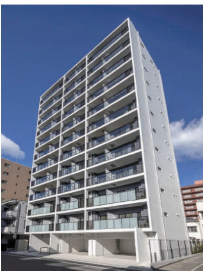
クレストコート本所吾妻橋 令和5年1月竣工
