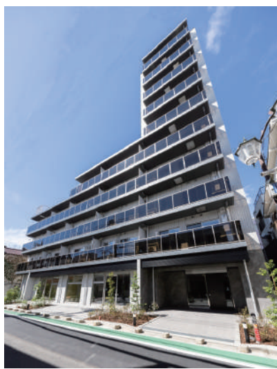
クレストコート江古田 令和6年6月竣工
