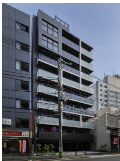
ARKMARK方南町Sta. 令和7年5月竣工
