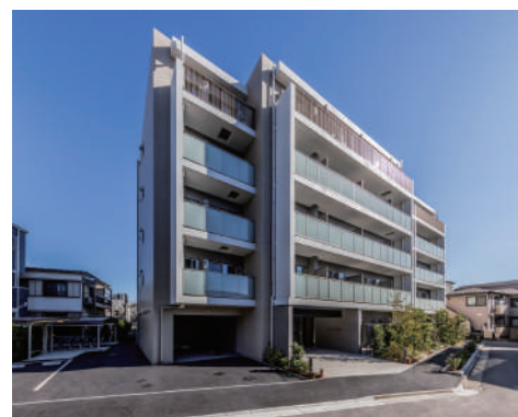
Alivis綾瀬 令和8年1月竣工
