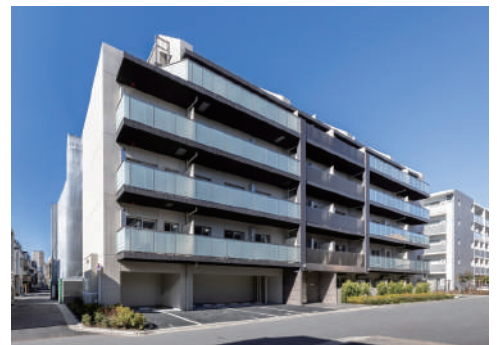
リテラス日暮里 令和6年1月竣工
