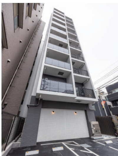
アーバンコア旗の台 令和7年5月竣工
