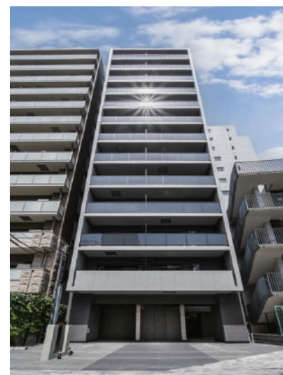
SEASON FLATS 武蔵小山 令和5年6月竣工
