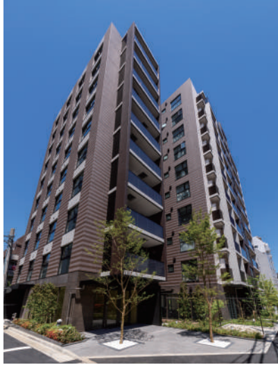
カーサスプレッディッド 恵比寿一丁目ANNEX 令和2年4月竣工
