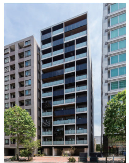
ミュプレ月島 令和3年5月竣工
