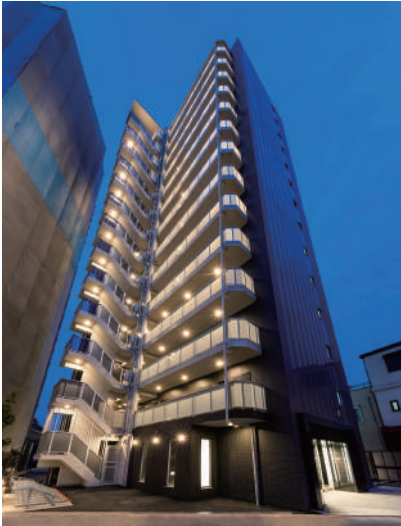
AZEST青砥 令和2年1月竣工
