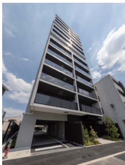
Alivis十条 令和7年7月竣工
