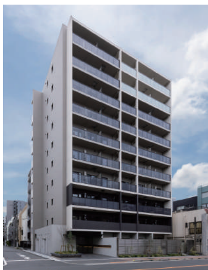
ALTERNA浅草 令和5年9月竣工
