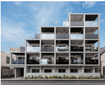
REALIZE新小岩 令和2年7月竣工
