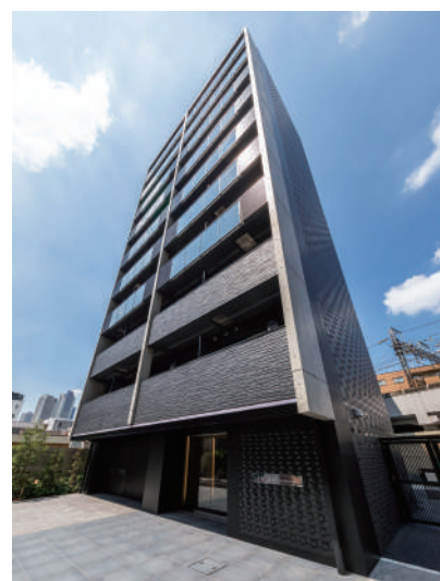
REALIZE新丸子 令和3年7月竣工
