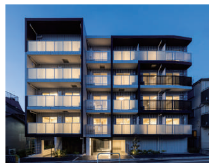
LUMEED赤羽NORTH 令和5年12月竣工
