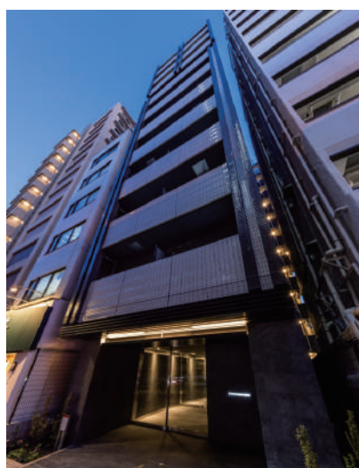
GRAND CONCIERGE駒沢大学 令和6年1月竣工
