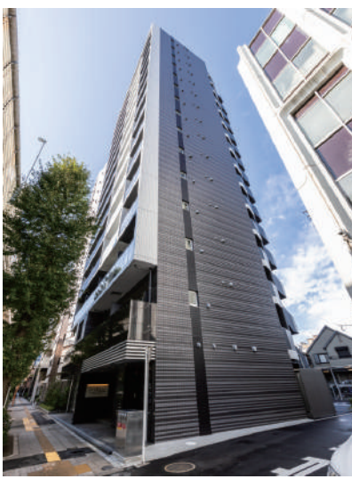
ARKMARK渋谷初台 令和5年11月竣工
