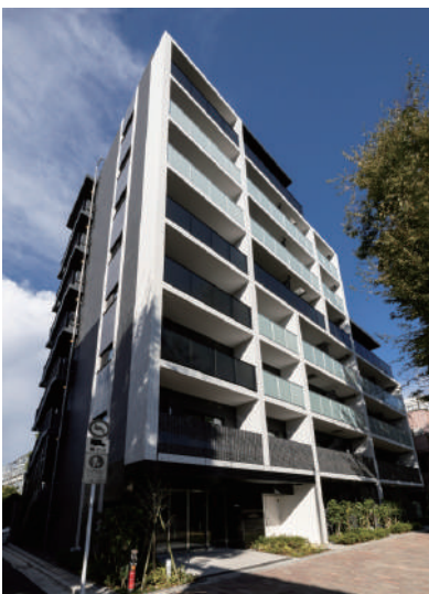
ARKMARK高円寺 令和5年11月竣工
