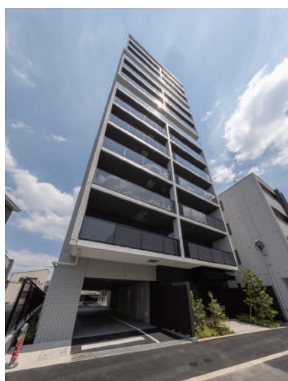
Alivis十条 令和7年7月竣工
