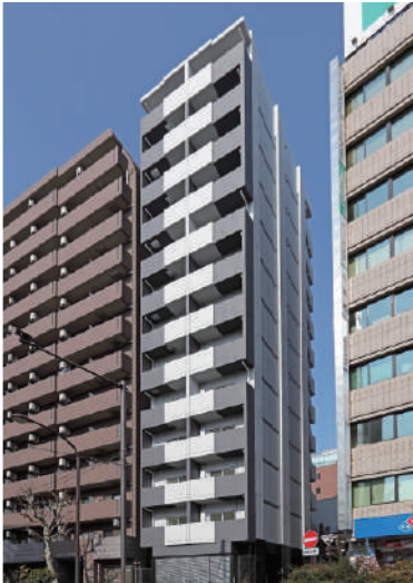
クレイシア三田 平成26年1月竣工
