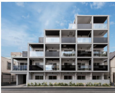
REALIZE新小岩 令和2年7月竣工
