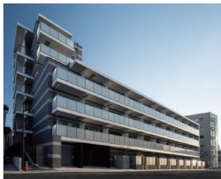
MAXIV西川口SC 令和5年12月竣工
