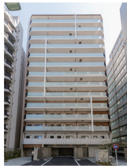
JP noie 西蒲田 令和7年5月竣工
