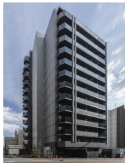
S-RESIDENCE松戸Cosmea 令和7年1月竣工
