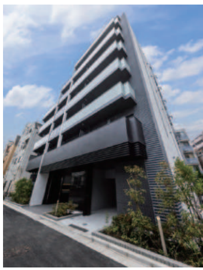
GENOVIA 押上II 令和5年6月竣工
