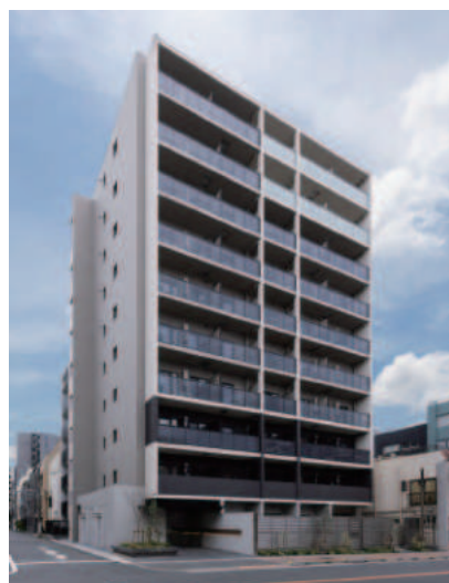
ALTERNA浅草 令和5年9月竣工
