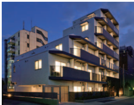
REALIZE綾瀬 平成27年12月竣工
