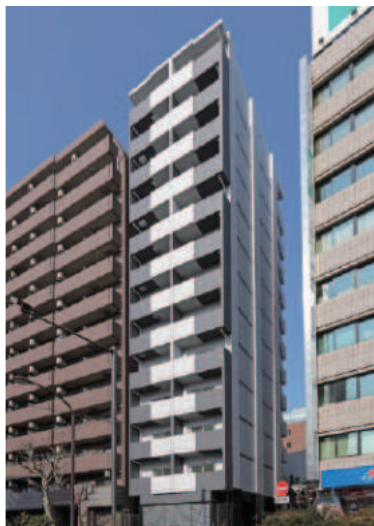
クレイシア三田 平成26年1月竣工
