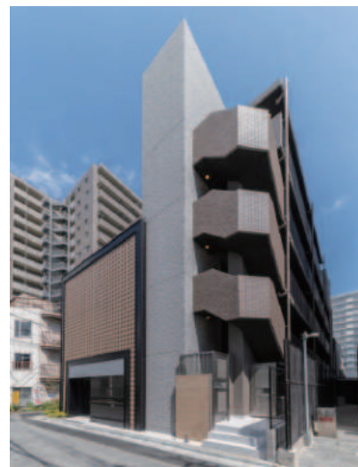
リテラス清澄白河 令和6年5月竣工
