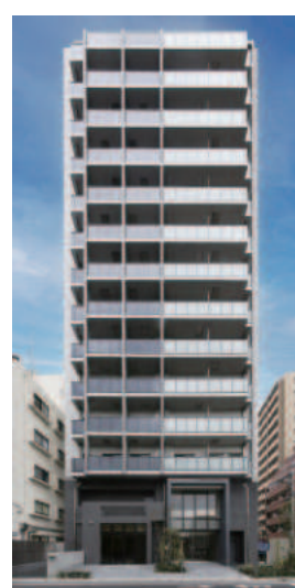
クレストコート池上 令和7年3月竣工
