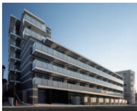
MAXIV西川口SC 令和5年12月竣工
