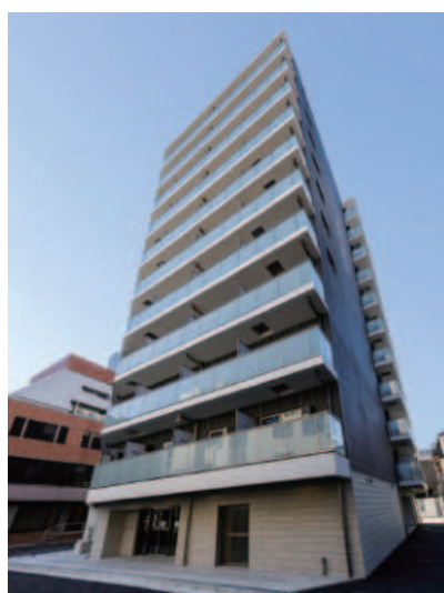
AZEST関内 令和5年2月竣工
