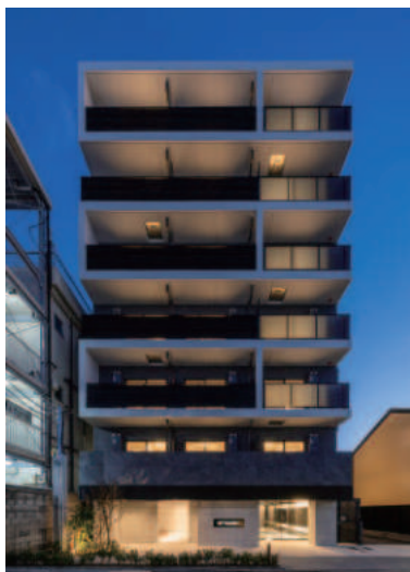
ガリシア竹ノ塚 令和6年11月竣工
