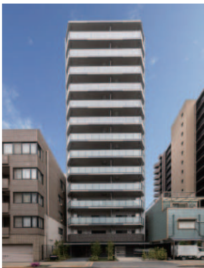
クレストコート上野 令和6年4月竣工
