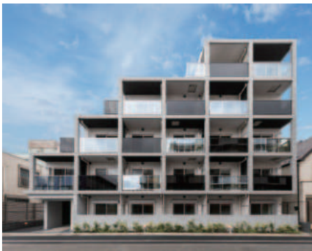
REALIZE新小岩 令和2年7月竣工
