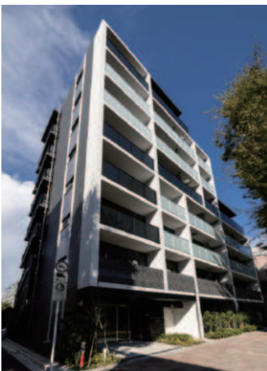
ARKMARK高円寺 令和5年11月竣工
