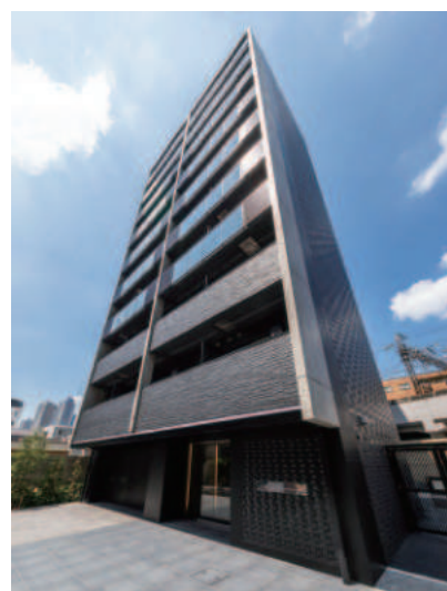
REALIZE新丸子 令和3年7月竣工
