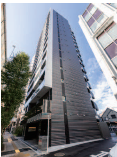
ARKMARK渋谷初台 令和5年11月竣工
