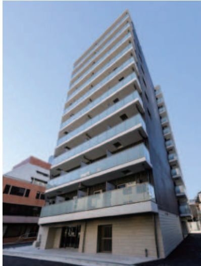
AZEST関内 令和5年3月竣工
