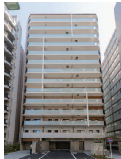
JP noie 西蒲田 令和7年5月竣工
