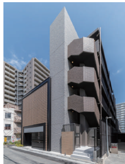
リテラス清澄白河 令和6年5月竣工
