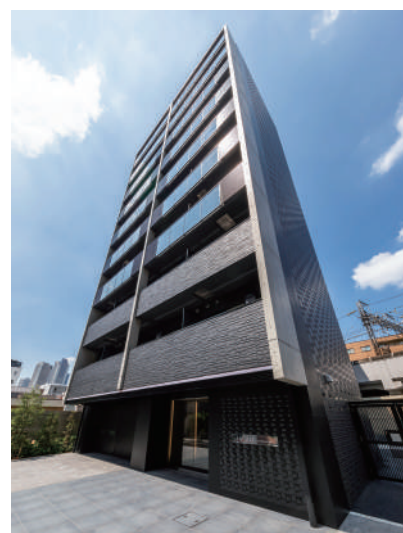
REALIZE新丸子 令和3年7月竣工
