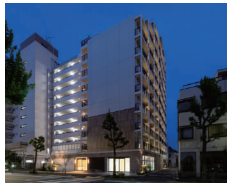
ALTERNA中野 令和5年5月竣工
