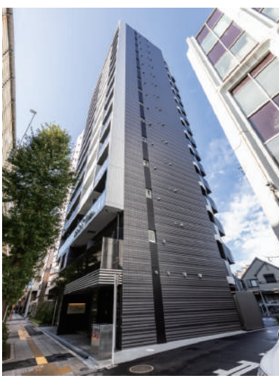
ARKMARK渋谷初台 令和5年11月竣工
