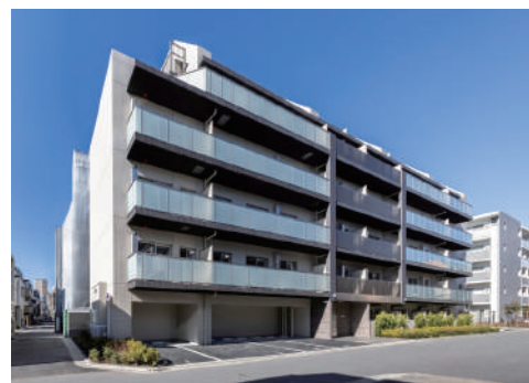
リテラス日暮里 令和6年1月竣工
