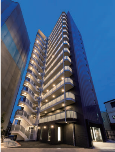
AZEST青砥 令和2年1月竣工
