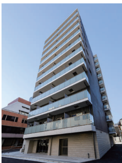
AZEST関内 令和5年2月竣工
