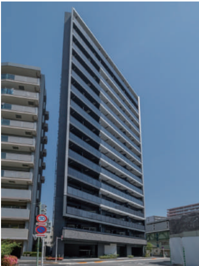
GALA STATION 大森海岸 令和5年5月竣工
