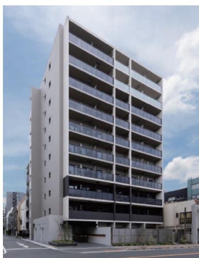
ALTERNA浅草 令和5年9月竣工
