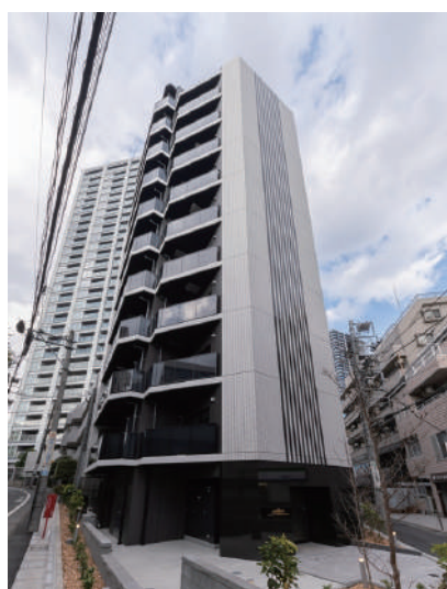
ラティエラ四谷 令和7年1月竣工
