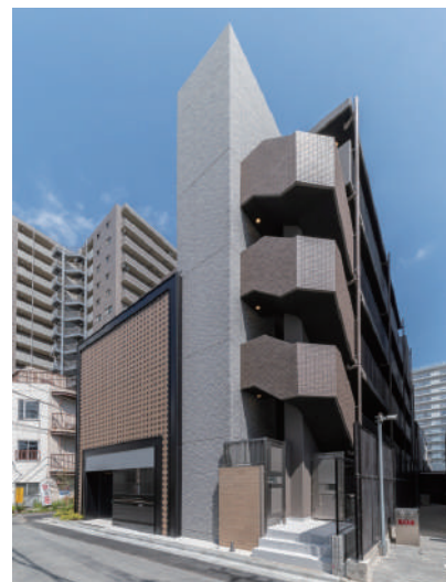
リテラス清澄白河 令和6年5月竣工
