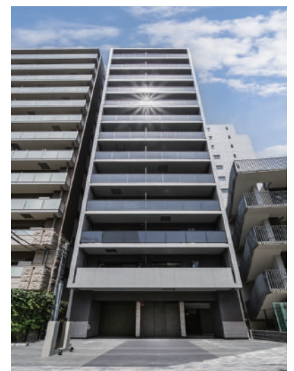
SEASON FLATS 武蔵小山 令和5年6月竣工
