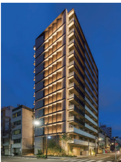
リーラ浅草橋 令和3年7月竣工
