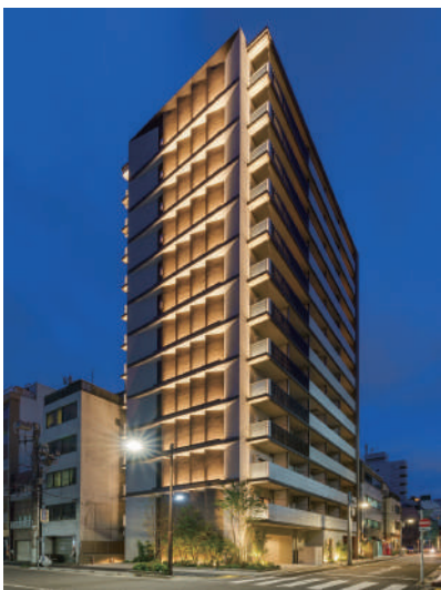
リーラ浅草橋 令和3年7月竣工
