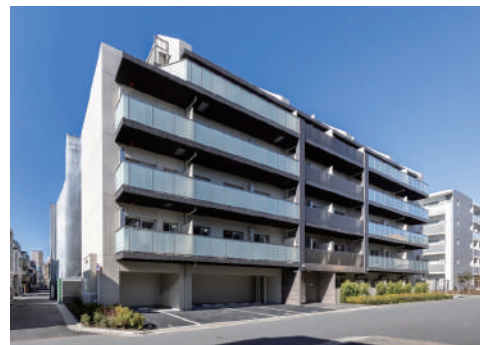
リテラス日暮里 令和6年1月竣工
