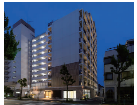
ALTERNA中野 令和5年5月竣工
