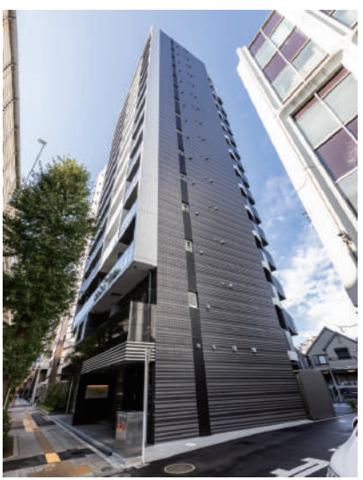
ARKMARK渋谷初台 令和5年11月竣工
