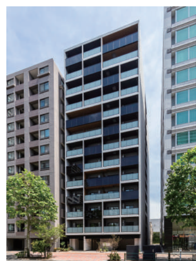
ミュプレ月島 令和3年5月竣工
