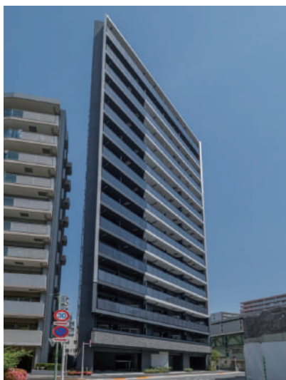
GALA STATION 大森海岸 令和5年5月竣工
