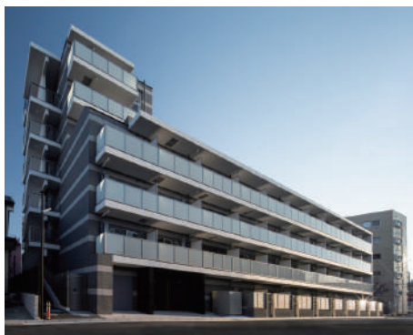
MAXIV西川口SC 令和5年12月竣工
