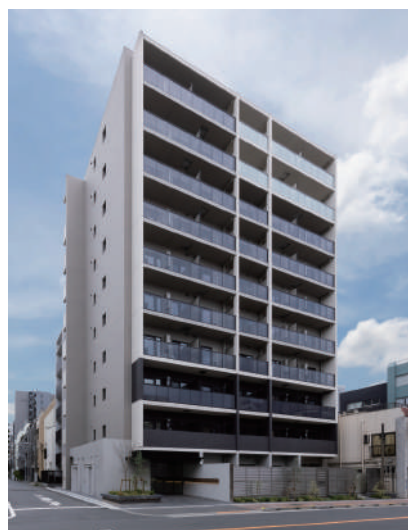
ALTERNA浅草 令和5年9月竣工
