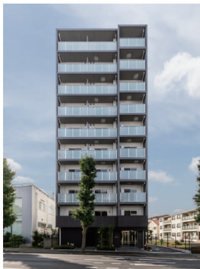
GENOVIA白糸台skygarden 令和5年10月竣工
