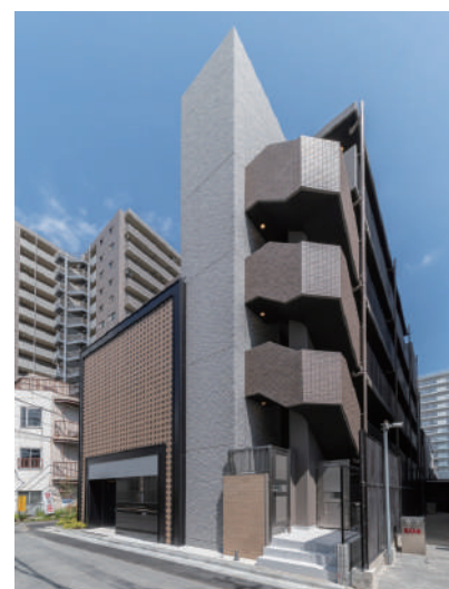
リテラス清澄白河 令和6年5月竣工
