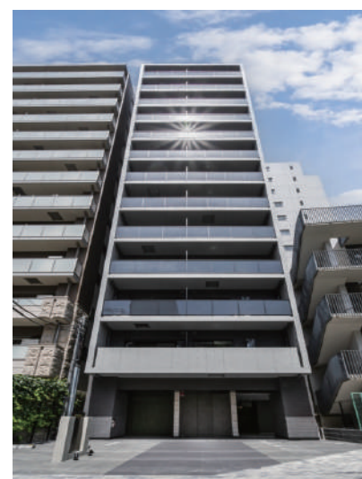
SEASON FLATS 武蔵小山 令和5年6月竣工
