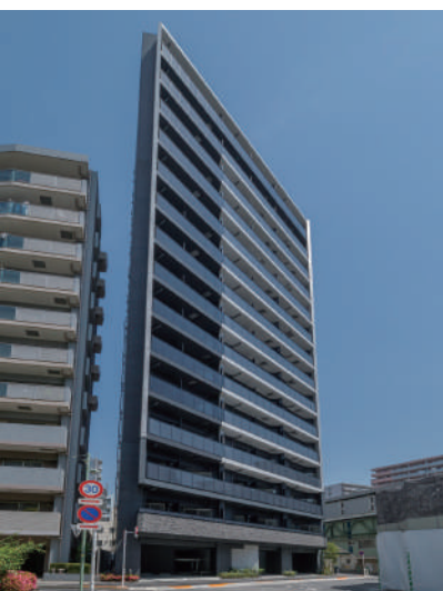
GALA STATION 大森海岸 令和5年5月竣工
