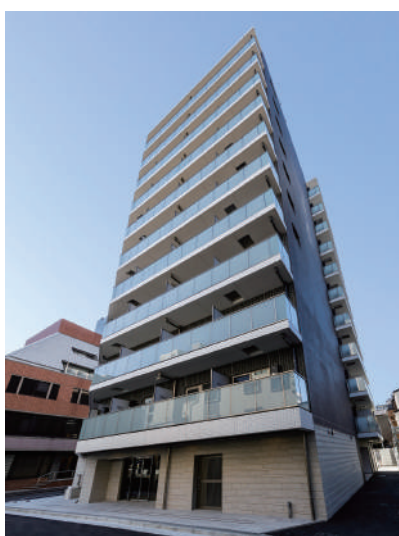
AZEST関内 令和5年2月竣工
