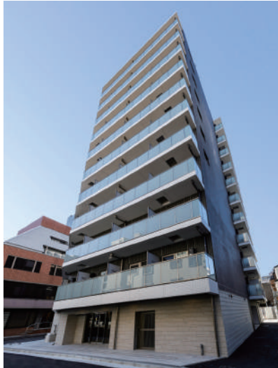
AZEST関内 令和5年3月竣工
