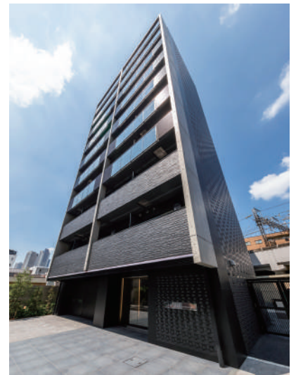
REALIZE新丸子 令和3年7月竣工
